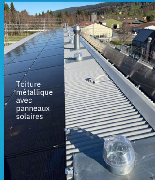
Utilisation d'une ancienne sortie de cheminée
