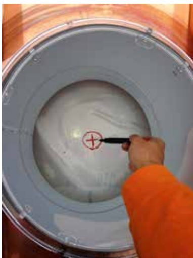
5 Neuer Zentrum auf Dampfsperre anzeichnen
