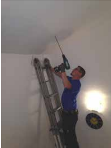
1 Solatube positionieren (Zentrum ausbohren)
