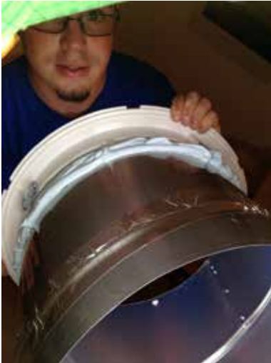
13 Primur auf Rohrumfang an richtiger Höhe aufstreichen
