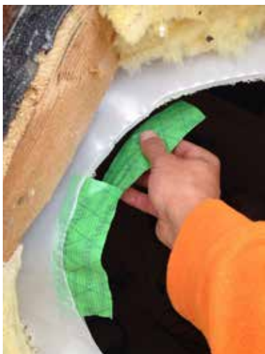
11 Lippe bei Dampfsperre erstellen
