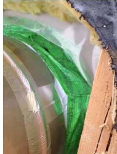
14 Überprüfung der Klebung zwischen Rohr und Lippe
