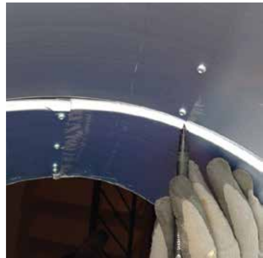
10 Winkelposition auf oberes und unteres Rohr anzeichnen
