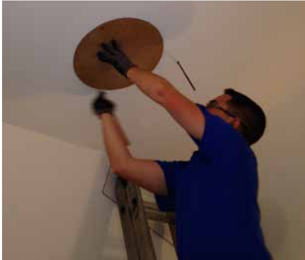
7 Definitive Stelle des Verteilers anzeichnen
