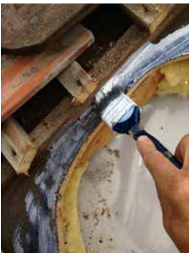
17 Primär anbringen und trocknen lassen
