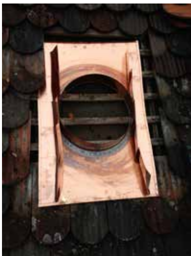
3 Fassung zwischen Ziegel und Dachsparren zentrieren
