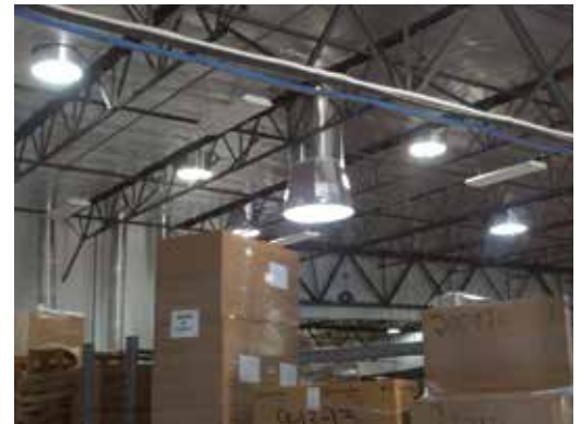
Halle de stockage
